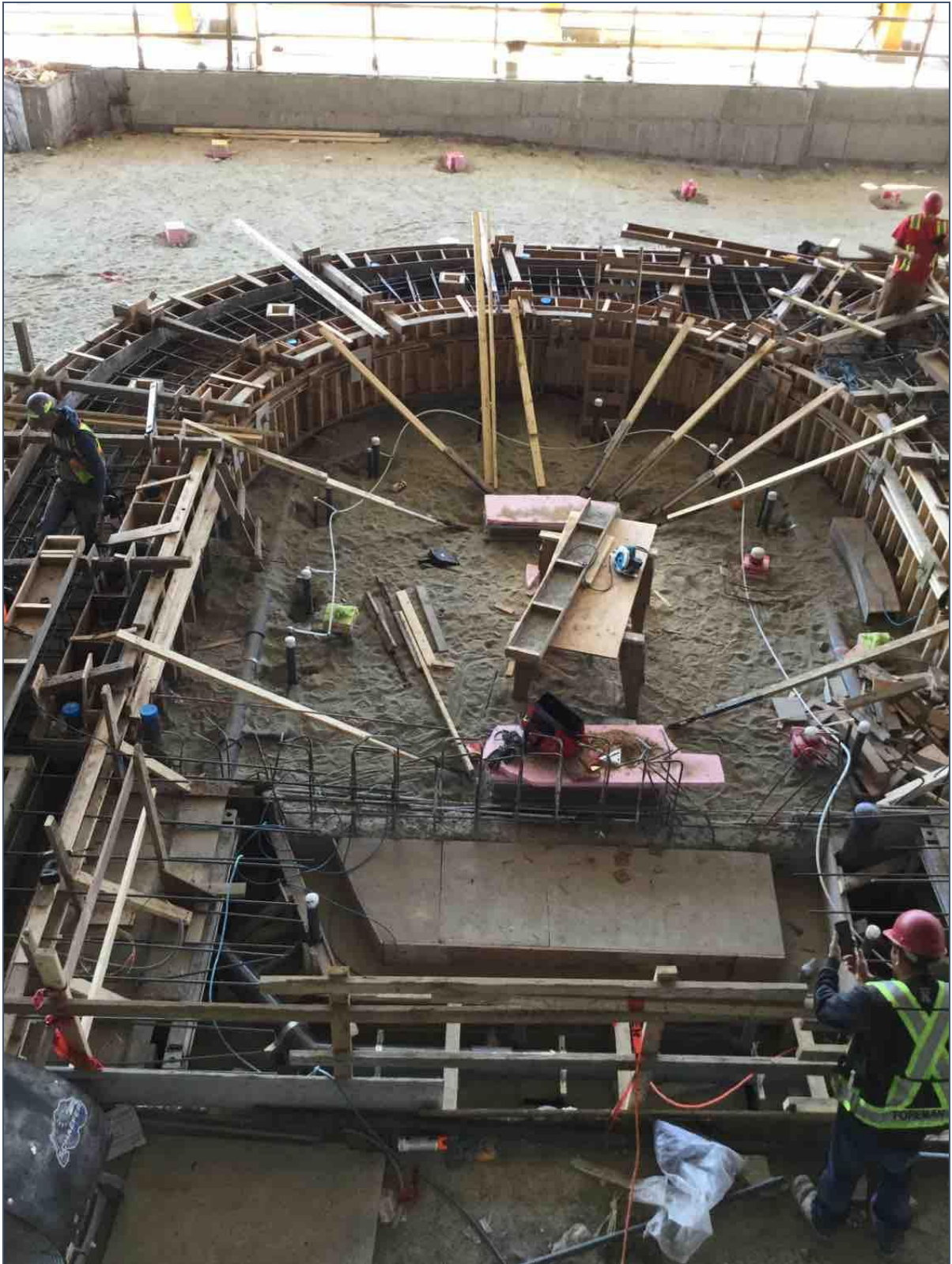
Phase 1C – Hot tub deck rebar placed for slab pour
